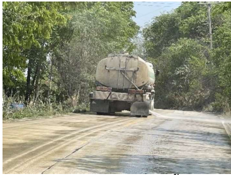
รูปที่ 2-9: การฉีดพรมน้ำ บริเวณเส้นทางลำเลียงแร่
